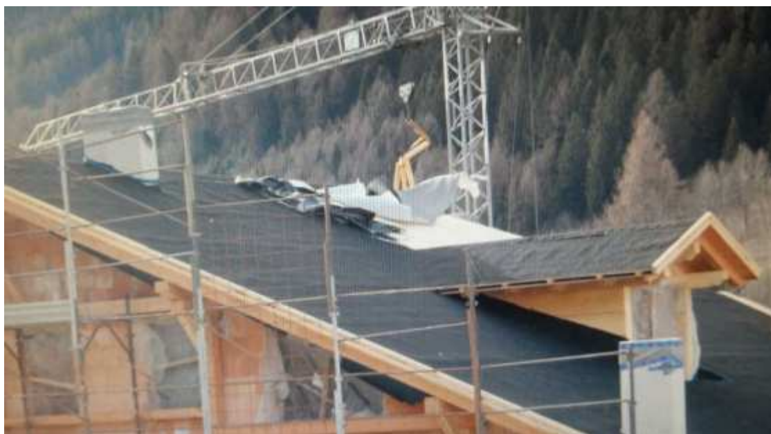
Figura 9. Danni alla copertura in lamiera dell'albergo di Pejo Fonti
