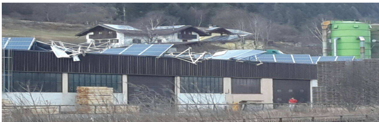
Figura 1. Pannelli solari danneggiati dalle raffiche di foehn a Spiazzo l'11 gennaio 2015.
