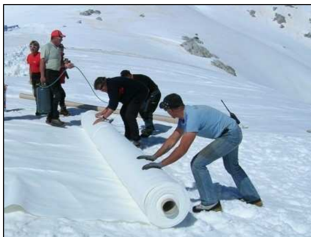
Posa geotessile (giugno)
