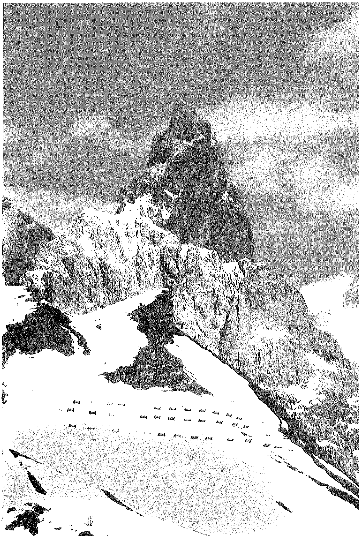
Il «Cimon della Pala» visto dal Passo Rolle: in primo piano opere paravalanghe a difesa della S.S. 50.
