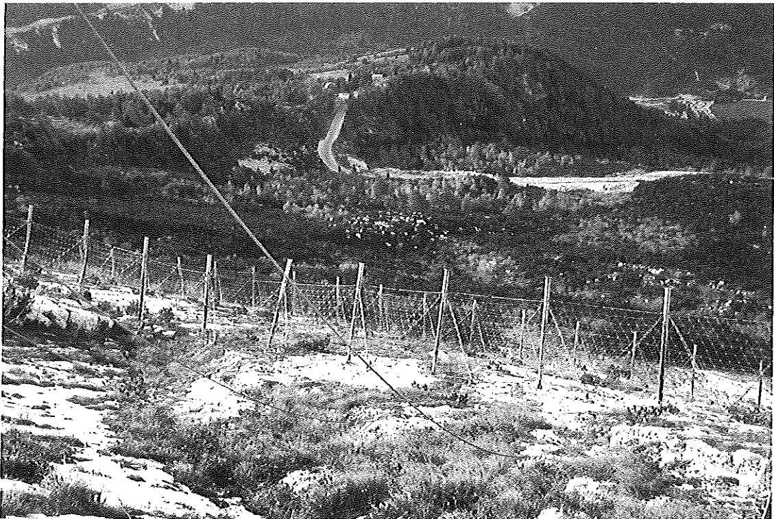
Reti paravalanghe in acciaio a difesa della S.P. 85 «del Monte Bondone» in loc. La Cuna (Trento).
