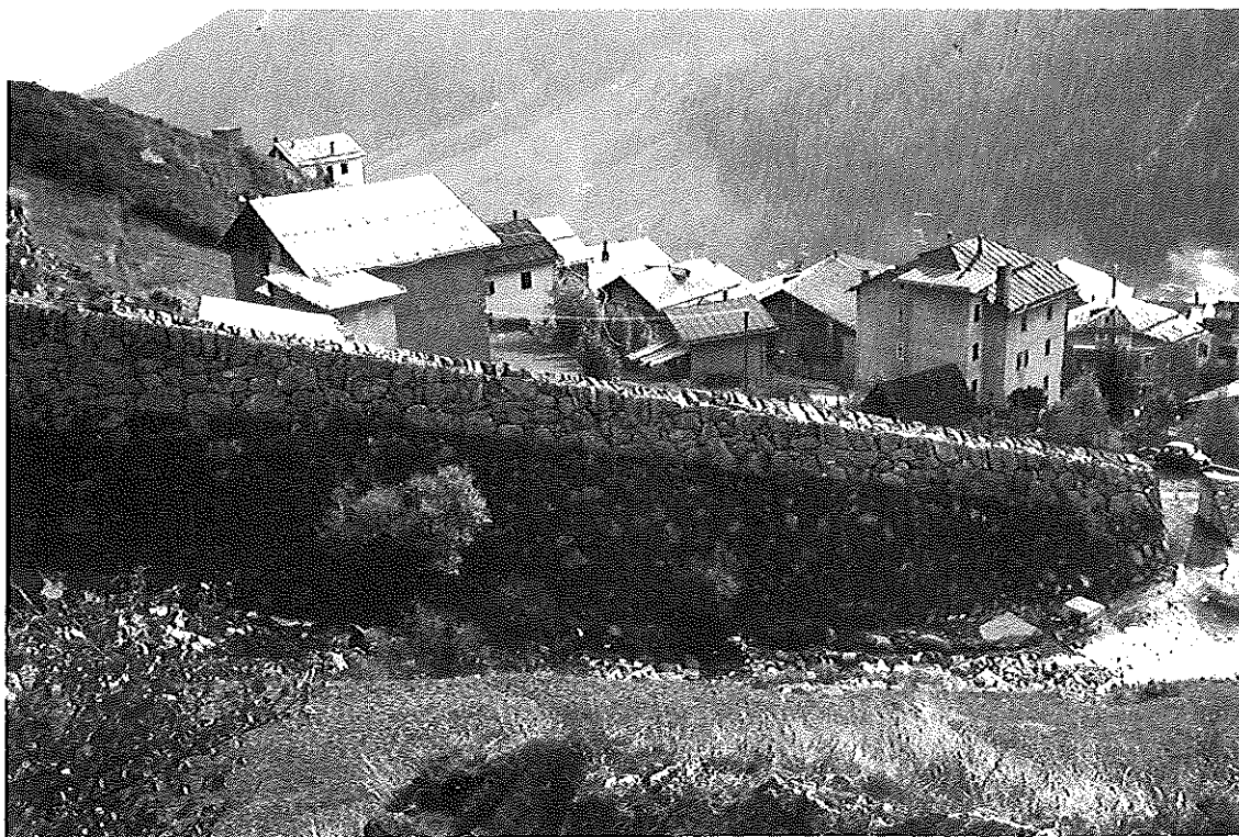
Argine in pietra a difesa dell'abitato di Vermiglio (Val di Sole).
