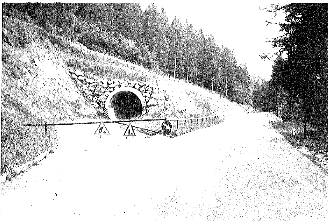
Galleria paravalanghe in elementi di acciaio a difesa della S.P. 79 del «Broccon» sul versante occidentale del Monte Agaro (Tesino).
