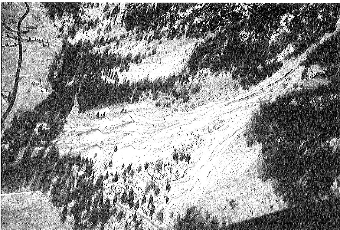
Cumuli frenanti in terrapieno a difesa della S.P. 86 di Rabbi e di case di abitazione in loc. Tassè (Val di Rabbi).
