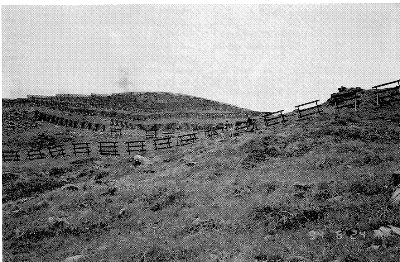
Castel Pagano m. 2594: opere paravalanghe, a difesa dell'abitato di S. Bernardo di Rabbi. (inizio lavori giugno 1993)
