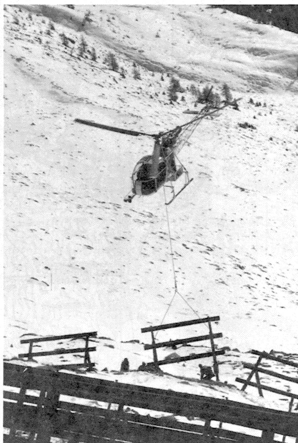
Messa in opera di ponti da neve in acciaio a difesa dell'abitato di S. Bernardo di Rabbi
