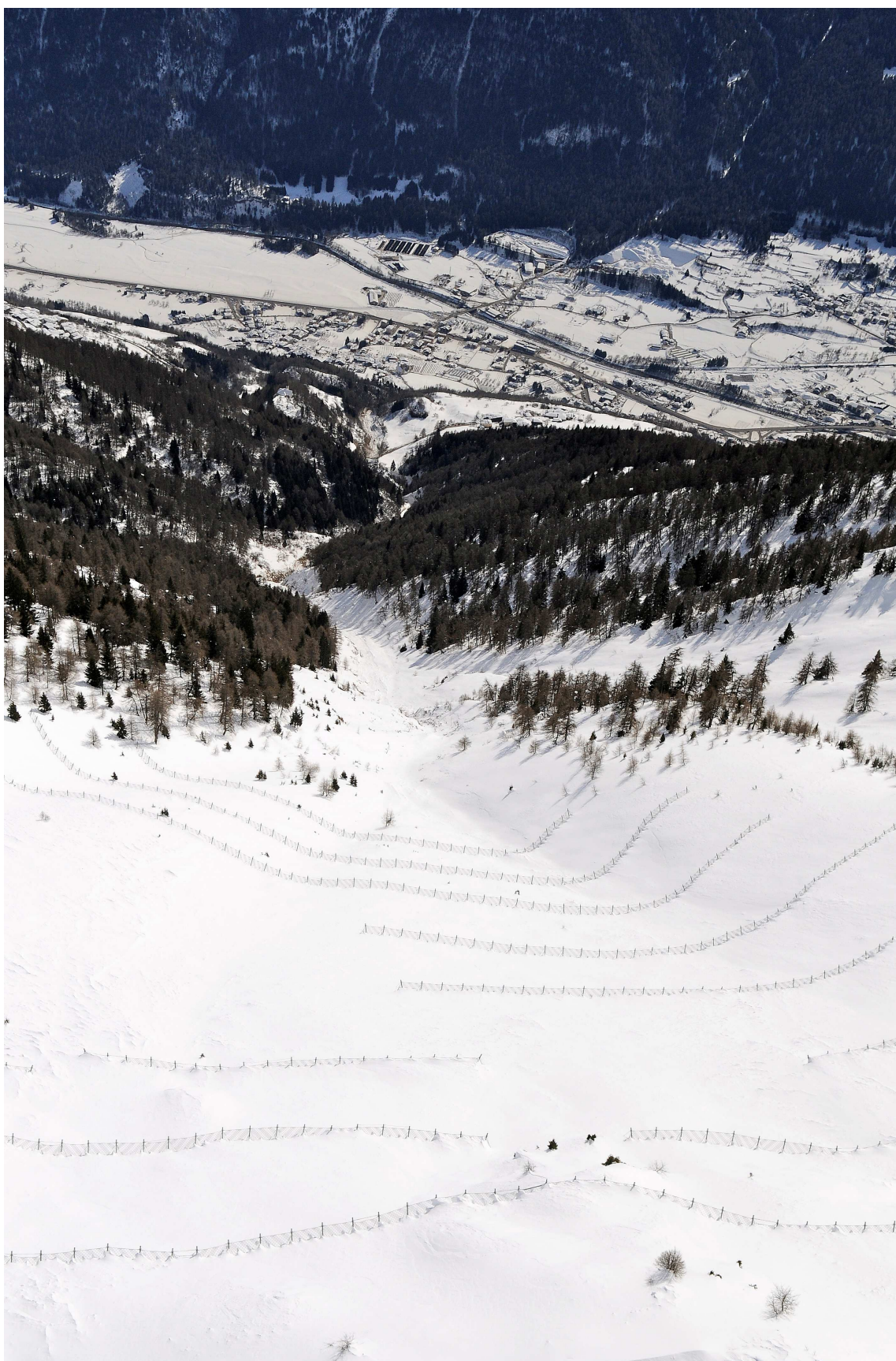
Figura 129: Cima Bolentina ed il canalone di S. Valentino (Monclassico) con le opere paravalanghe al limite della loro capacità di ritenuta
